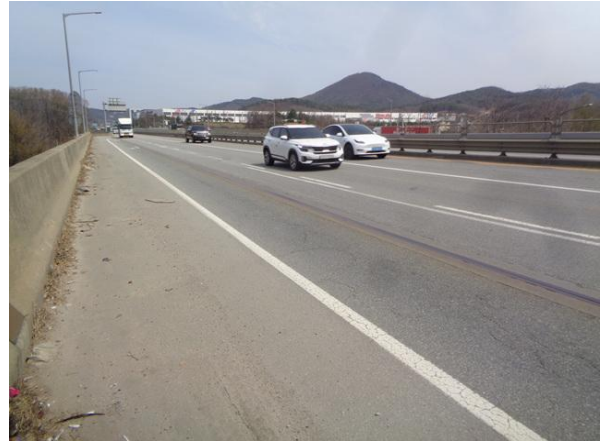
교량 상부 전경
