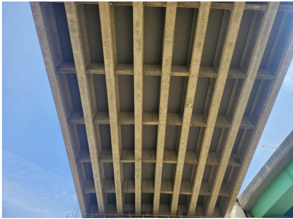
바닥판 하면 및 거더 전경
