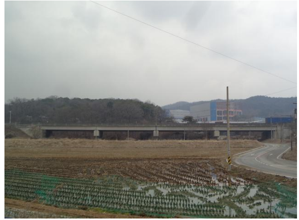
교량 측면 전경
