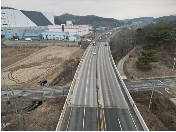
교량 상부 전경
